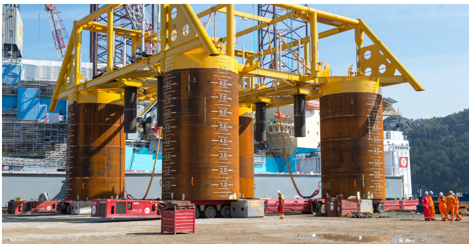
En havbunnsramme til undervannsproduksjon lastes om bord
