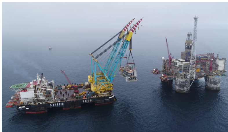
Løftefartøyet Saipem 7000 løfter gassbe-handlingsmodulen for Dvalin om bord på Heidrun-plattformen.
